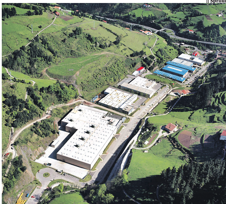
Polígono Azitain Barren - Eibar (Gipuzkoa), gestionado por Sprilur.
